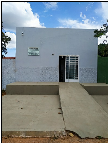
Fachada da serventia com rampa de acessibilidade para PCD. Placa de identificação sem a descrição do nome do interino.
