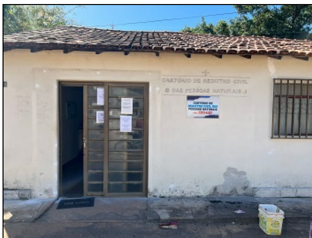
Identificação da serventia sem o nome da Delegatária e com pintura desgastada.
