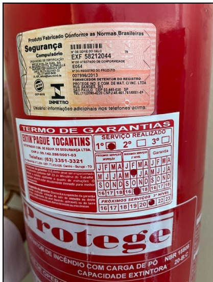
Banheiro sem acessibilidade e extintor de incêndio com recarga vencida.
