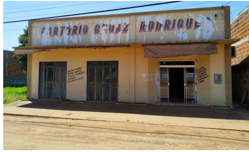
Entrada da Serventia sem acessibilidade e a fachada em estado precário
