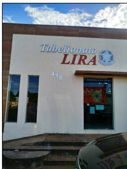
Fachada sem a identificação adequada do nome da Titular e as atribuições da serventia.
