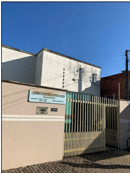
Fachada da serventia com identificação, rampa de acessibilidade e segurança.
